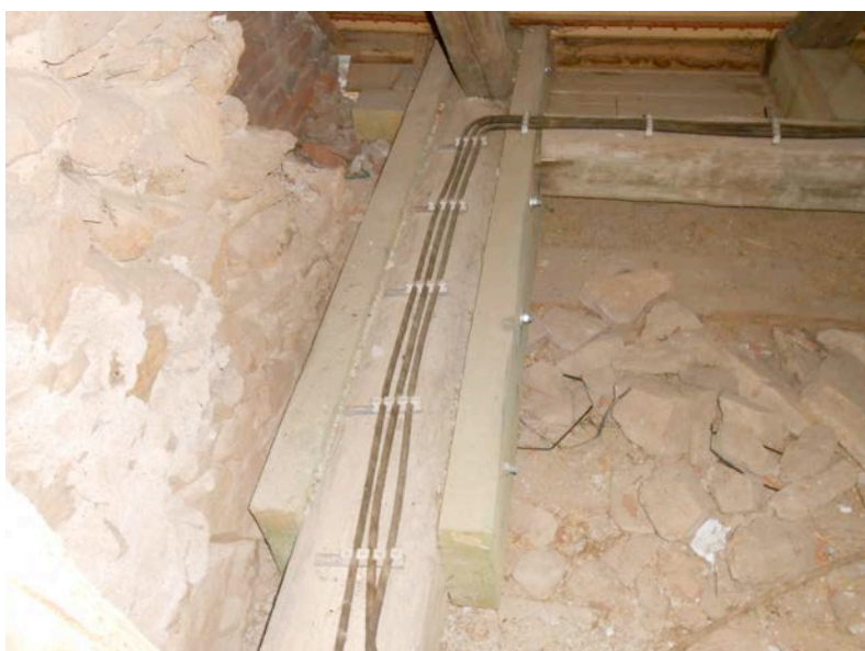
Foto č.11: Vyztužení vazního trámu při rekonstrukci
