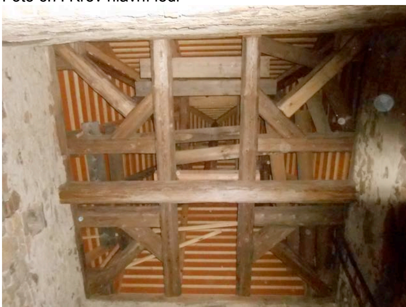
Foto č.8: Krov věže
