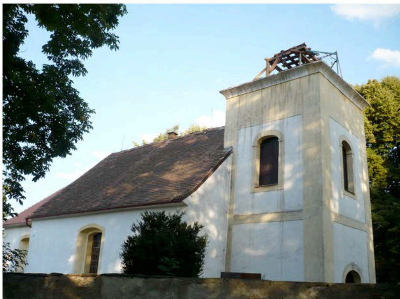
Foto č.2: Odkrytá věž kostela při rekonstrukci střechy v roce 2007
