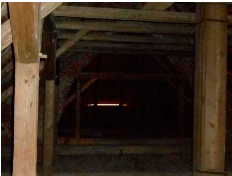
Foto č.9: Krov presbytáře
