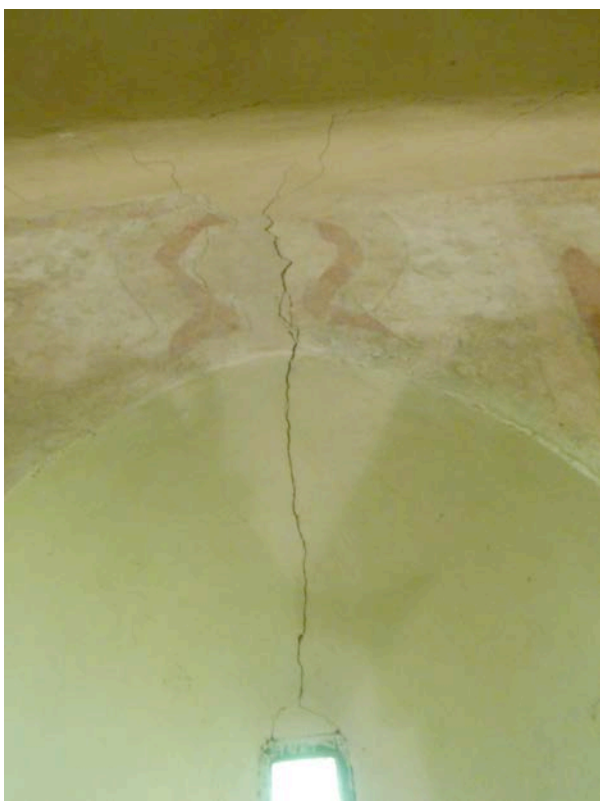
Foto č.17, 18: Prasklina nad gotickým oknem presbytáře prostupující celým zdivem
