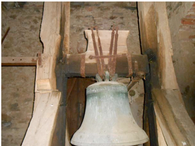
Foto č.10: Osazení zvonu ve věži
