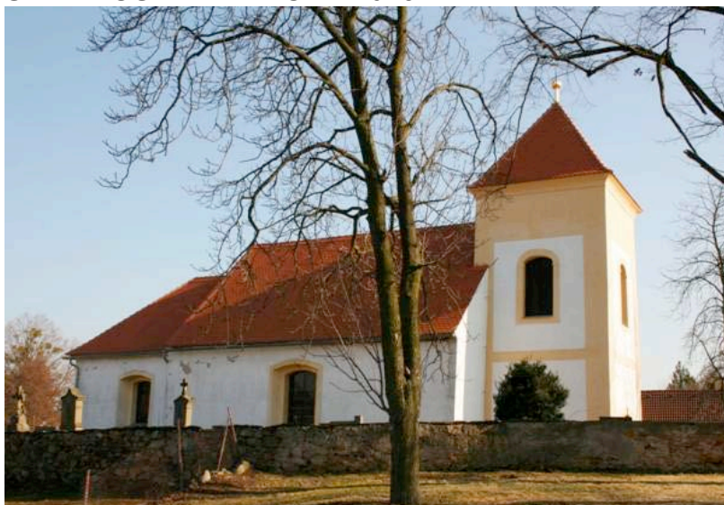
Foto č.4: Severní stěna
