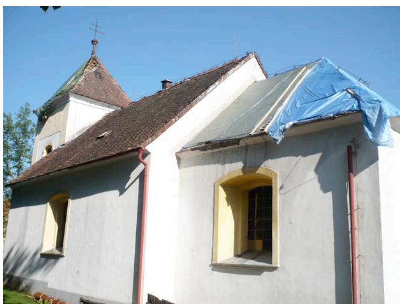
Foto č.3: Jihovýchodní pohled při rekonstrukci střechy v roce 2007
