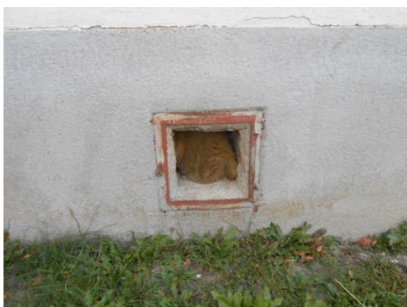
Foto č.21,22: Větrací otvory v soklovém zdivu
