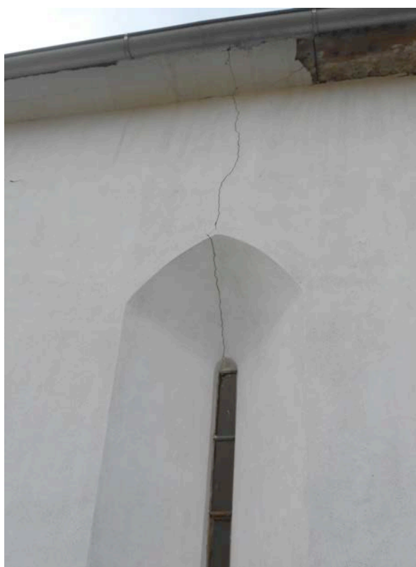
Foto č.17, 18: Prasklina nad gotickým oknem presbytáře prostupující celým zdivem
